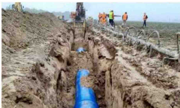
Un cantiere di Acquevenete per la posa di tubazioni d'acquedotto
